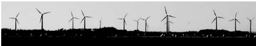
можно заменить генераторы электроэнергии, работающие за счёт сжигания нефти и угля. Сооружения на рисунке — это ветряные мельницы с лопастями, которые вращаются за счёт ветра. Благодаря этим вращениям генераторы производят электрический ток.
