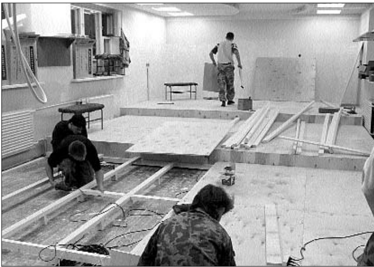
Лекционный зал до ремонта...
