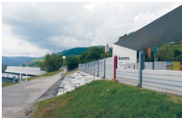
Рис. 1. Так выглядит придунайская стена для защиты от наводнения
