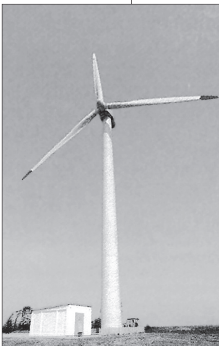
Современная ветроэлектростанция. Ветряная установка мощностью 600 кВт построена в Тверской области в конце XX в.
