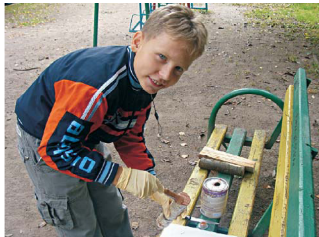
Рис. 14. Закрашивание торцов масляной краской
