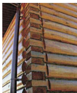
Рис. 6. Угол дома с соединением бревен «в лапу»
