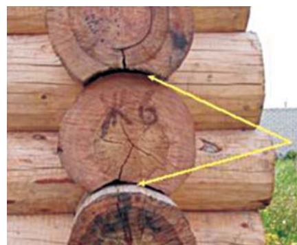
Рис. 5. Угол дома с соединением бревен «в чашу»
