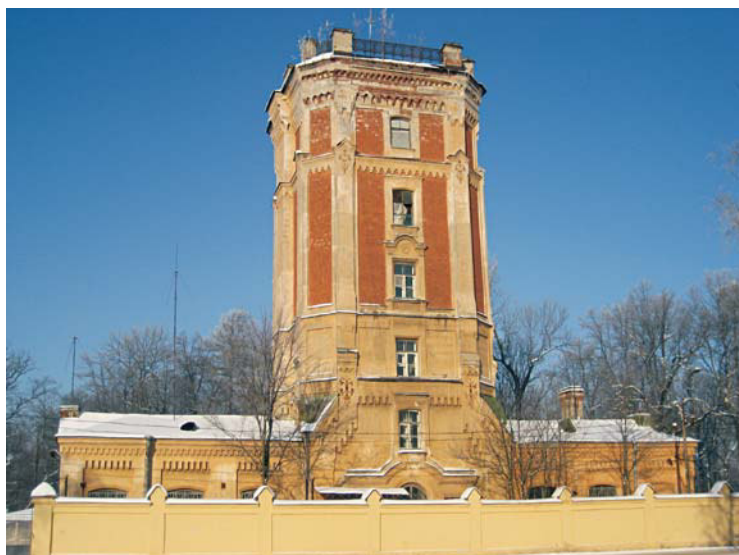
Орловская водонапорная башня. Фото 2007 г. (Водоподъемное здание у Таицкого водовода)
