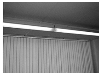
Светильник с регулируемой яркостью. Соединение светильников в «световую линию»
