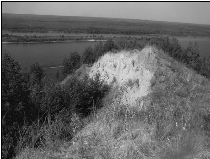
Рис 1. Оползень на Волжском откосе
